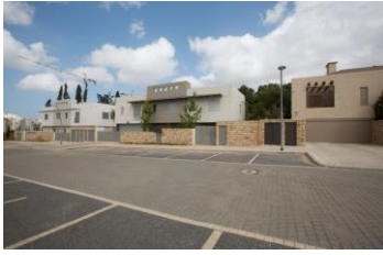
איור 14 | שכונת היולות שנבנתה בסמוך לגן
