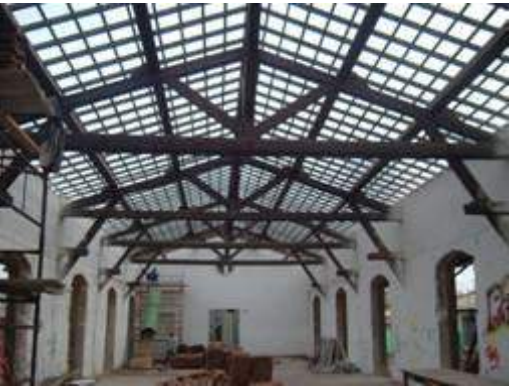
4. קונסטרוקציית גג הרעפים, מחסן הסחורות, תחנת הרכבת התורכית, יפו.
