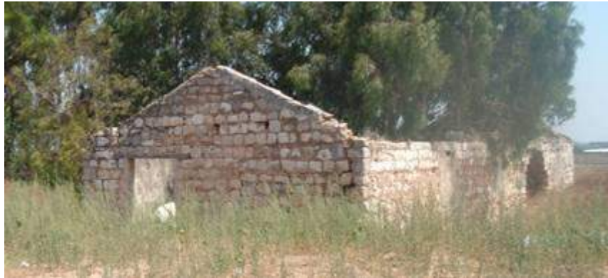
מבנה הממוקם מזרחית לאזור כפר סבא הערבית. המבנה דומה בבנייתו לח'אן אלא שצידו החיצוני לא מטויח. ניתן לראות בבירור את מבנה הקיר בבניית ד-פנים כשתי שורות אבנים ובניהם "דבש".
