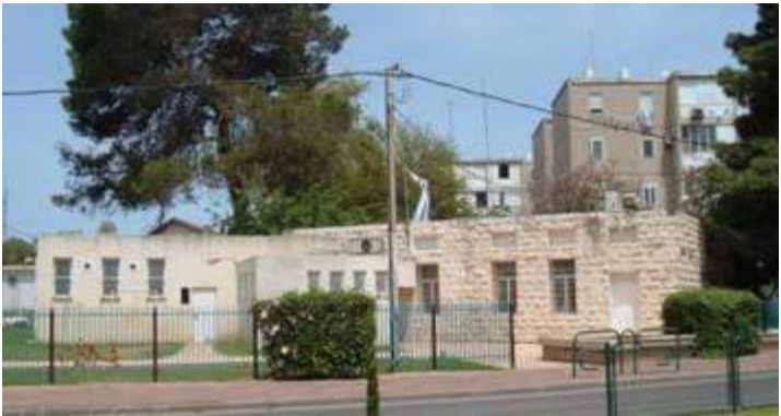
"בית האבן", המבנה היחיד שנותר מכפר סבא הערבית. למבנה קירות אבן כאשר צידם החיצוני גלוי. בדוגמא זו ניתן לראות מבנה בעל רמת סיתות גבוהה יותר המעיד על חשיבות המבנה, אשר שימש כבית ספר.
