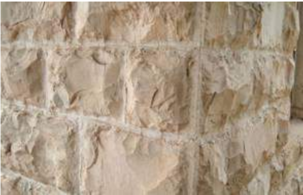
"בית האבן", המבנה היחיד שנותר מכפר סבא הערבית. למבנה קירות אבן כאשר צידם החיצוני גלוי. בדוגמא זו ניתן לראות מבנה בעל רמת סיתות גבוהה יותר המעיד על חשיבות המבנה, אשר שימש כבית ספר.
