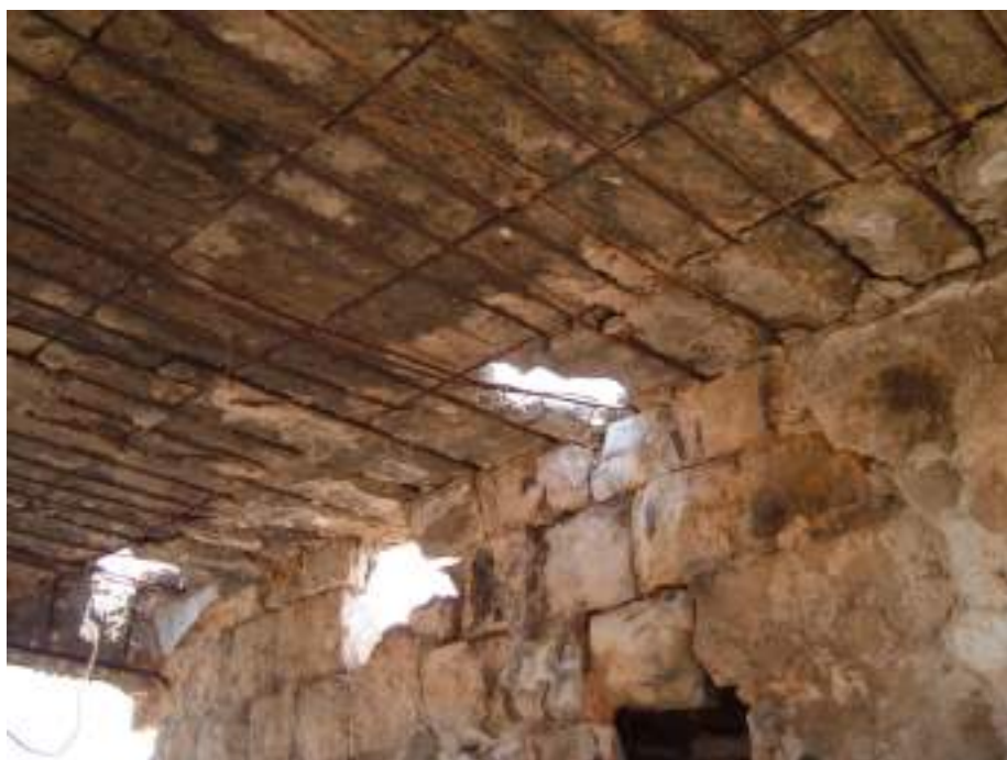
על גבי הבית מאבן בנייה נוספת מבטון מזוין מתקופת החווה החקלאית היהודית
