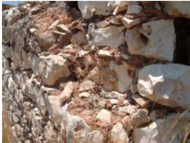
קיר דו פני , שני שורות אבן ובאמצע חומר מליטה עשוי בוץ
