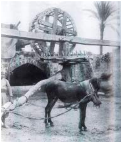
באר אנטייליה- שאיבת מים בעזרת גלגלי שיניים עשויים עץ ומופעל על ידי בהמה. הטכנולוגיה רווחה בבארות במישור החוף בא"י עד המאה העשרים והכנסת המנוע המוטורי. מקור: מנשה דודזון, "משק ההדרים היהודי בא"י"
