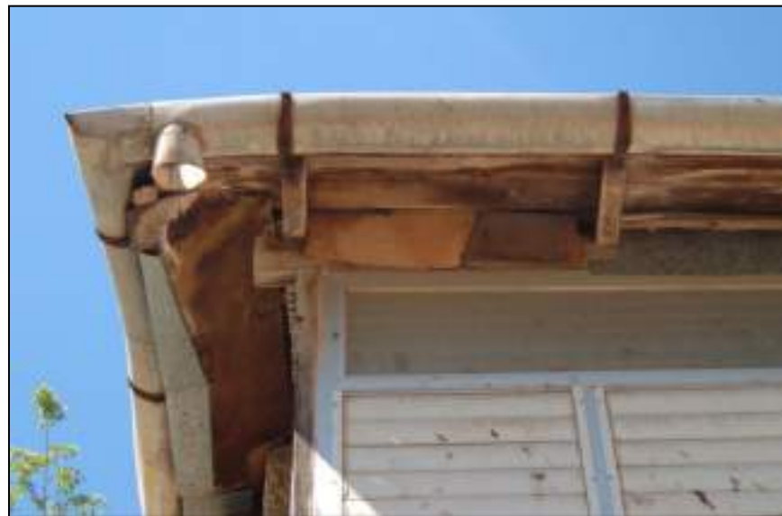
4. קצה גג רעפים, ארגז רוח ומרחב פח מעוגל פתוח בהיקף הגג, פינה דרום מערבית של גג מרפסת צפונית
