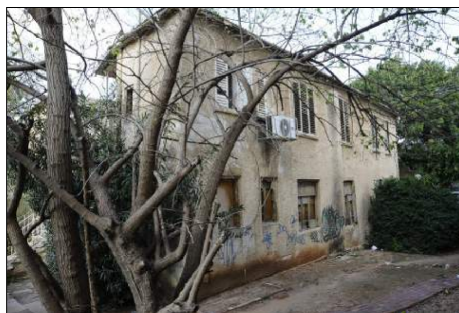
4. פרטי נגרות פגועים, רטיבות העולה מהקרקע, תריסי פלסטיק במקום תריסי עץ, גרפיטי
