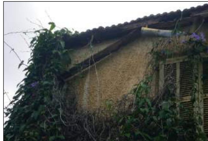
3. קצה גג רעפים ומרחב פח מעוגל פתוח בהיקף הגג, בקטע זה המרחב הרוס. פינה צפון מזרחית של גג ארבע שיפועים
