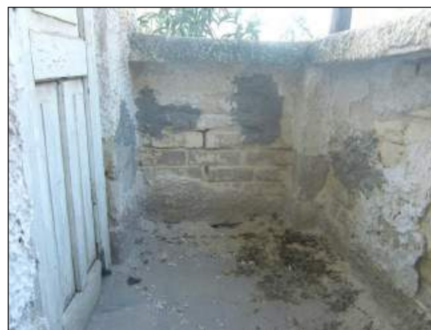
3. התפוררות טיח, חשיפת לבני זיפזיף, בלית חומר, תיקוני בטון
