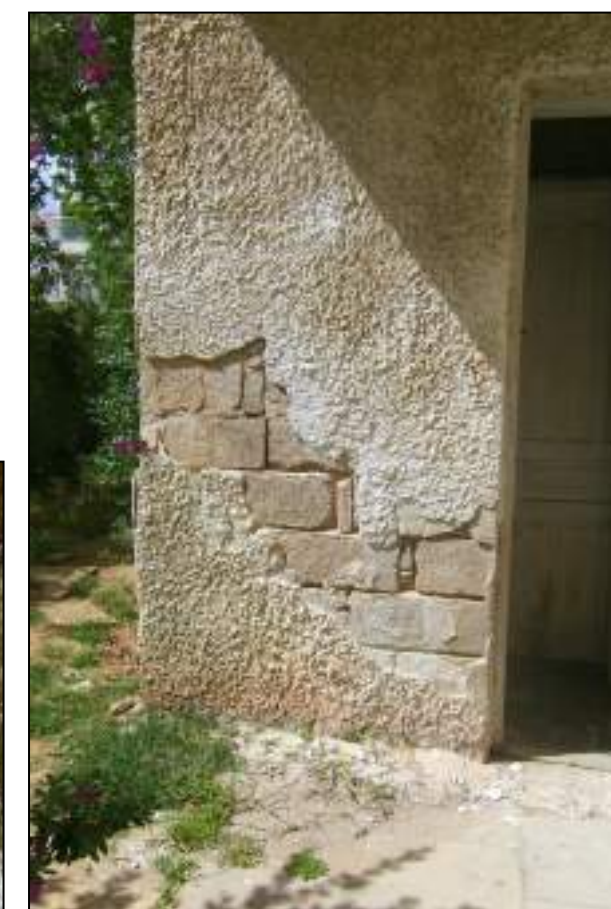
1. התפוררות טיח שפריץ וחשיפת בלוק זיפזיף, בלית חומר במישקים
