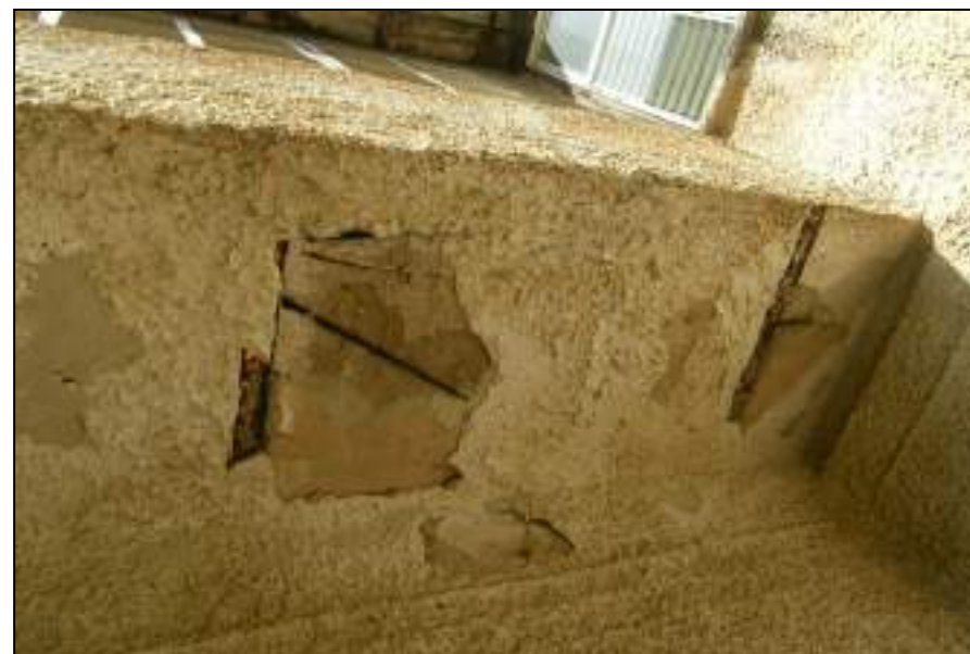
2. התפוררות בטון וטיח במרפסת וחשיפת קורות הברזל
