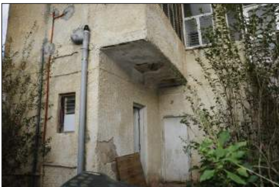
2. התפוררות בטון וטיח במרפסת וחשיפת קורות הברזל, תשתיות חיצוניות ותיקוני בטון על חזיתות המבנה
