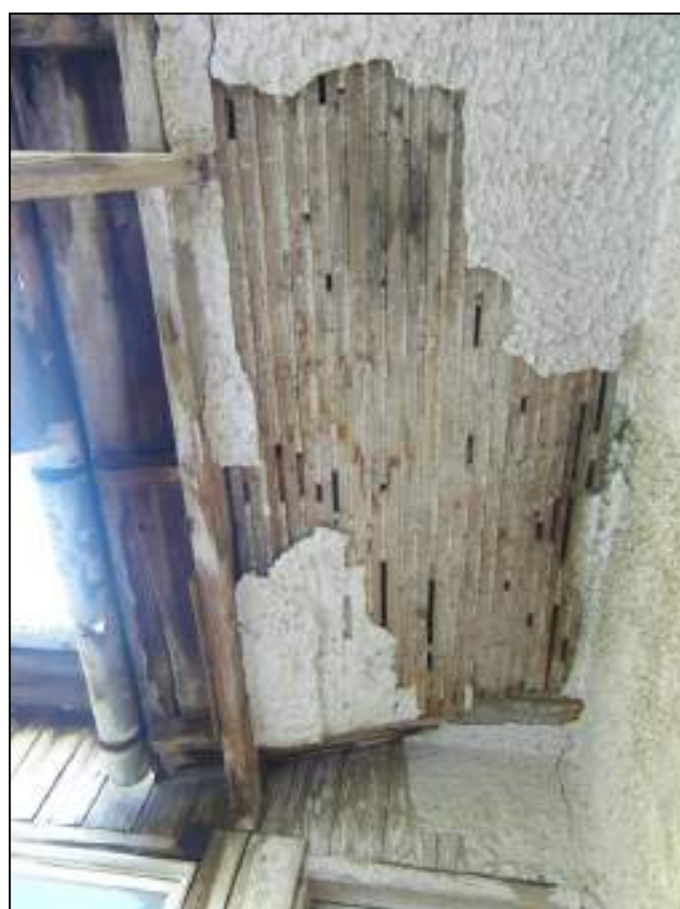
4. חשיפת תקרה וגג מקוריים, קונסטרוקציית גג עץ רקובה ומתפוררת
