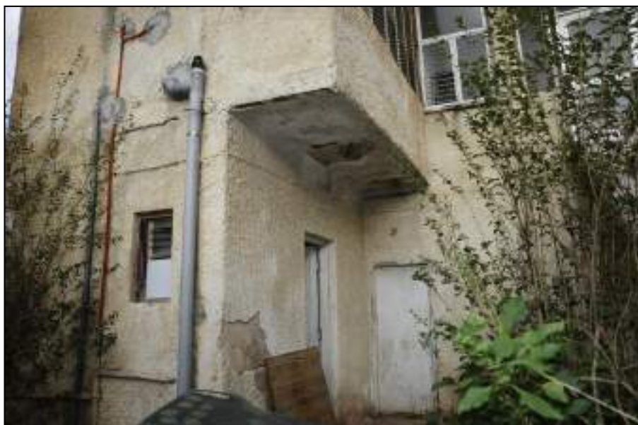
3. התפוררות בטון וטיח במרפסת וחשיפת קורות הברזל, תשתיות חיצוניות על חזיתות המבנה
