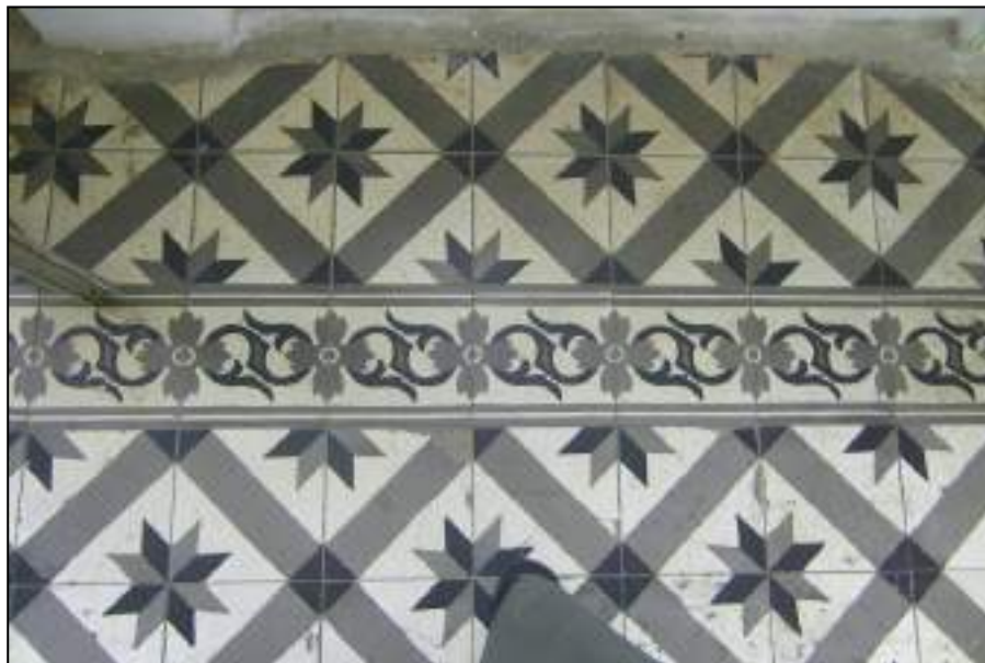
ר - 3 ריצוף אריחי בטון מעוטרים כולל מסגרת היקפית במרפסת קומה ראשונה בחזית מערבית, דגם זה קיים גם במבנה ברחוב רוטשילד 55
