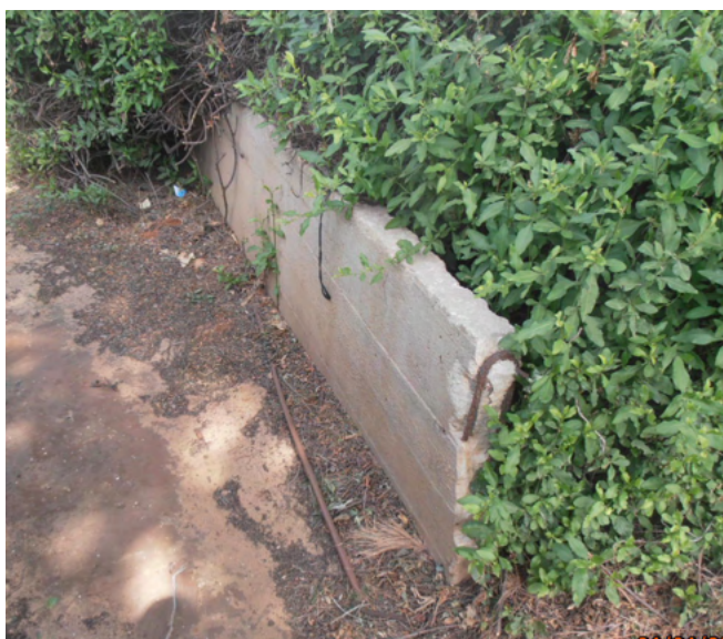
הקירות ההיקפיים של הגן וכן קיר פנימי התוחם את "במת הגן" תוכננו ובוצעו מבטון מזויין - גדר "בטון חזית" עם לוחות (תבניות) אופנהיים. בחלק מהקירות נראים עמודי הגדר ההיקפית
